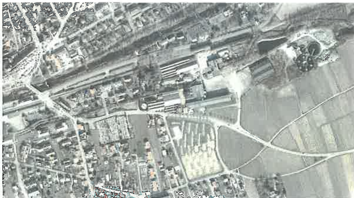
Photo aérienne 2012 (source :infogéo68)
